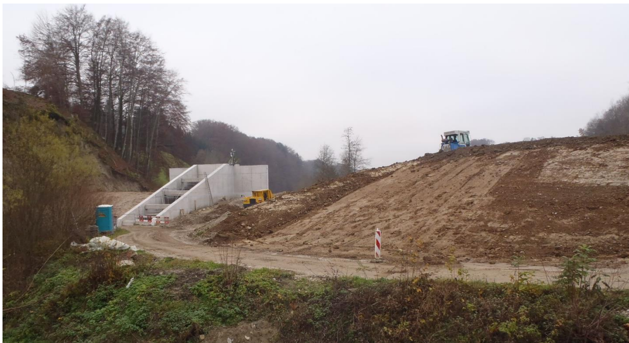
Abb. 7 Teilweise überströmbarer, homogener Erddamm mit geschlossenem Durchlassbauwerk im Bau (HRB Chappelebach, Wynigen Kanton Bern)
