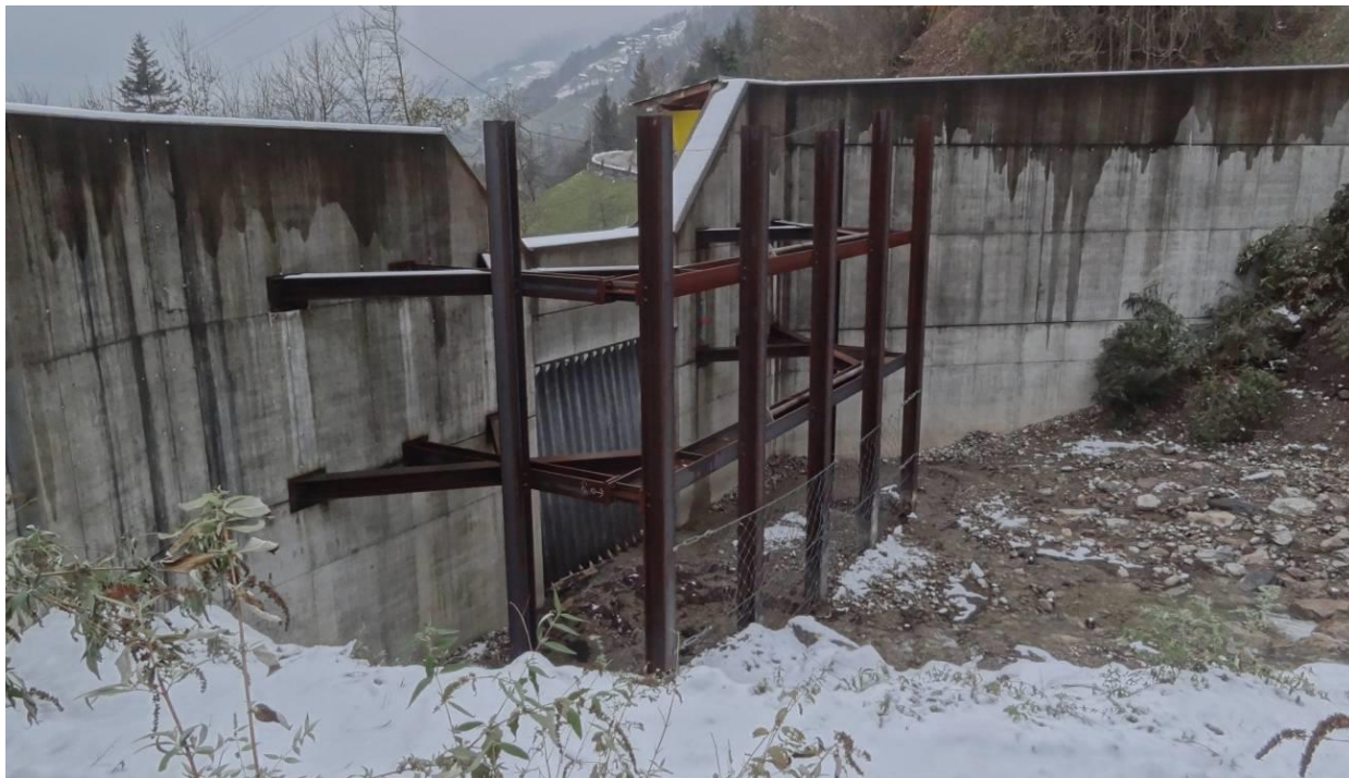
Abb. 3 Geschieberückhaltebecken am Kegelhals des Altdorfbachs mit vorgeschalteter Stahlkonstruktion.
