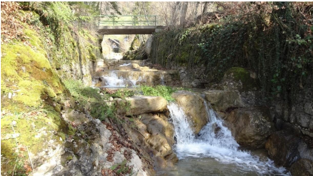
Abb. 1 Gerinne mit Bachsohlenschwellen aus Blöcken und Mauern an den Bachböschungen.
