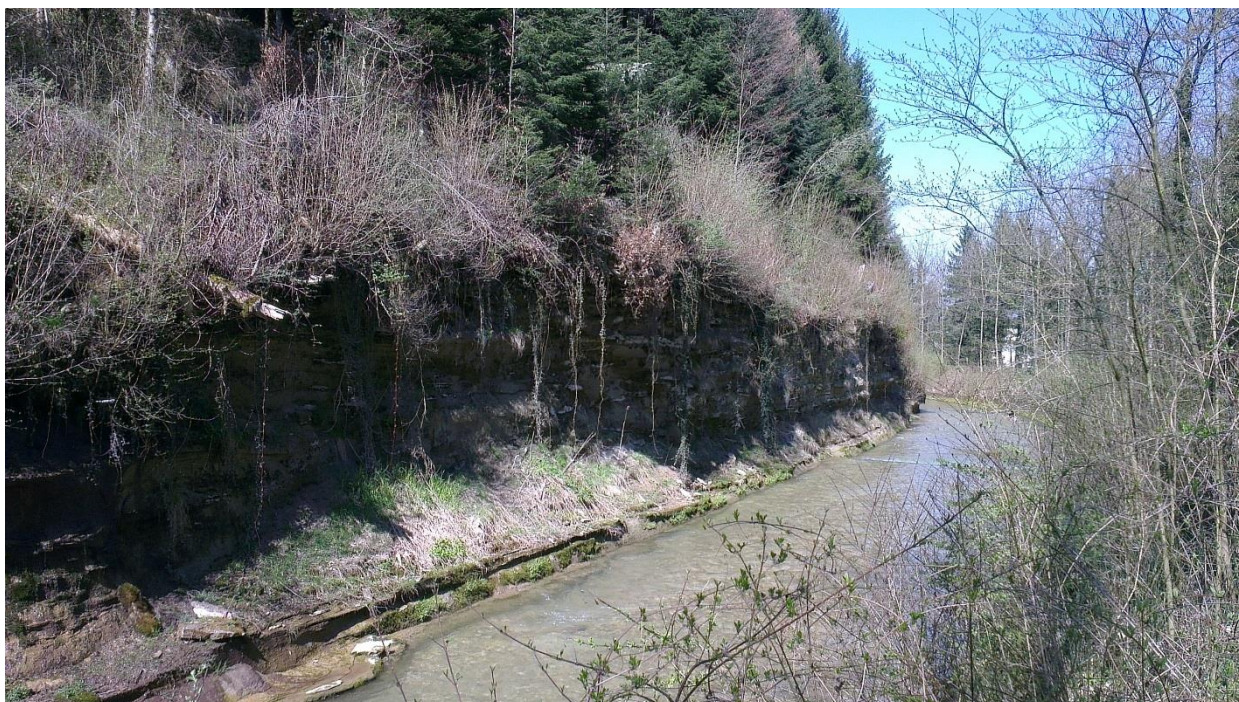
Abb. 1 ein Abschnitt der Luthern, in dem Rutschungen aus dem linksseitigen Hang den Abflussquerschnitt verlegen könnten
