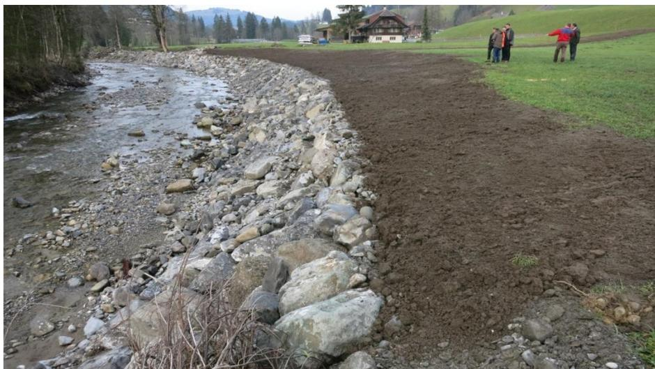
**Abb. 6** Erodierter Prallhang in Schangnau (vgl. Abb. 5) nach dessen Wiederherstellung mittels Blocksatz auf einem Holzrost sowie mit einem neu erstellten Doppeltrapezprofil (Blick in Fliessrichtung). Die Bepflanzung erfolgt im Frühling 2016.
