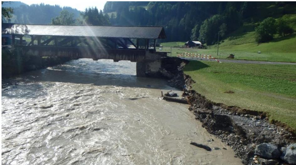
**Abb. 4** Zerstörter Uferverbau an der Emme und hinterspültes Brückenwiderlager der Büetschlibrücke, Gemeindegebiet von Schangnau (Blick in Fließrichtung).
