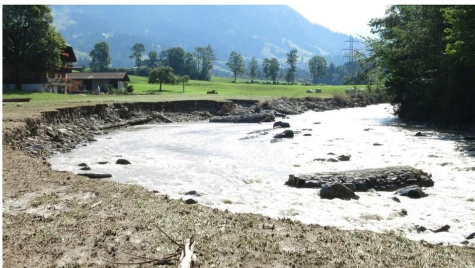
**Abb. 5** Hinterspülte Buhnen sowie Ufererosionsbreiten von bis zu 15 m bei Bumbach, Gemeindegebiet von Schangnau (Blick gegen Fließrichtung).
