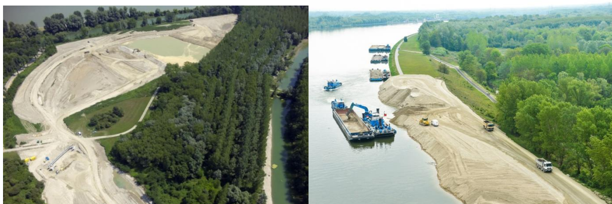
Abb. 12 Umlandabsenkung im Bau mit Kiesentnahme, offenem Grundwasser und wieder eingebrachtem Feinsediment (links, Foto G.Pock), Kiesverladestelle im Stauraum des Donaukraftwerks Altenwörth (rechts, Foto Markus Haslinger extremfotos.com)
