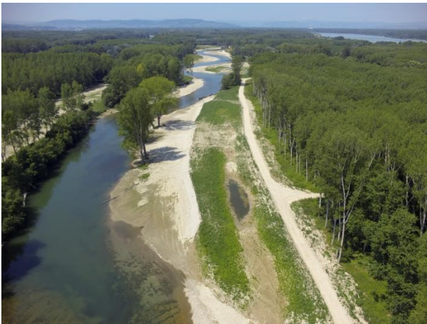
Abb. 9 HQ 1 -Bett des mittleren Bauabschnittes (links), schmale, bereits bewachsene Umlandabsenkung (rechts) (Foto G.Pock)
