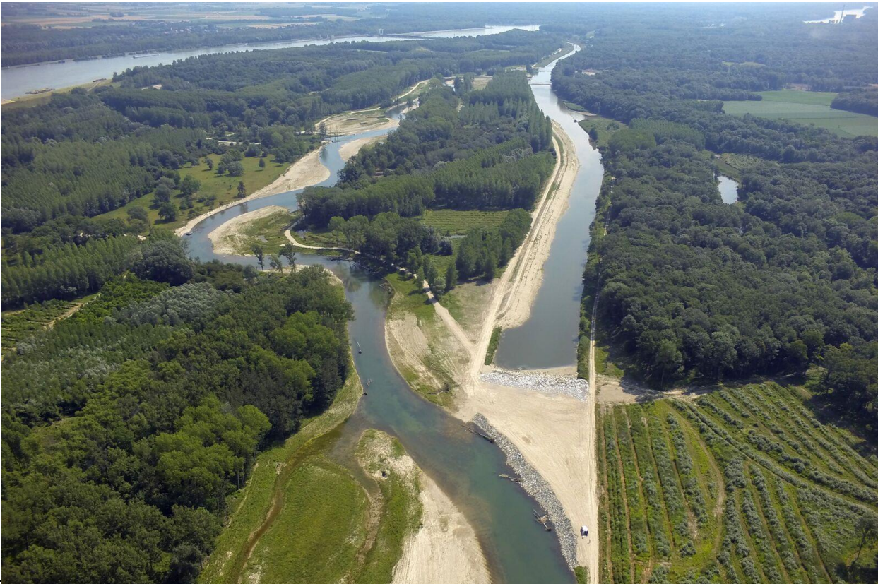
Abb. 6 oberer Teil des mittleren Bauabschnitte sowie Ableitungsbauwerk und bestehende („alte“) Traisen ca. 3 Monate nach Flutung (Foto G.Pock)
