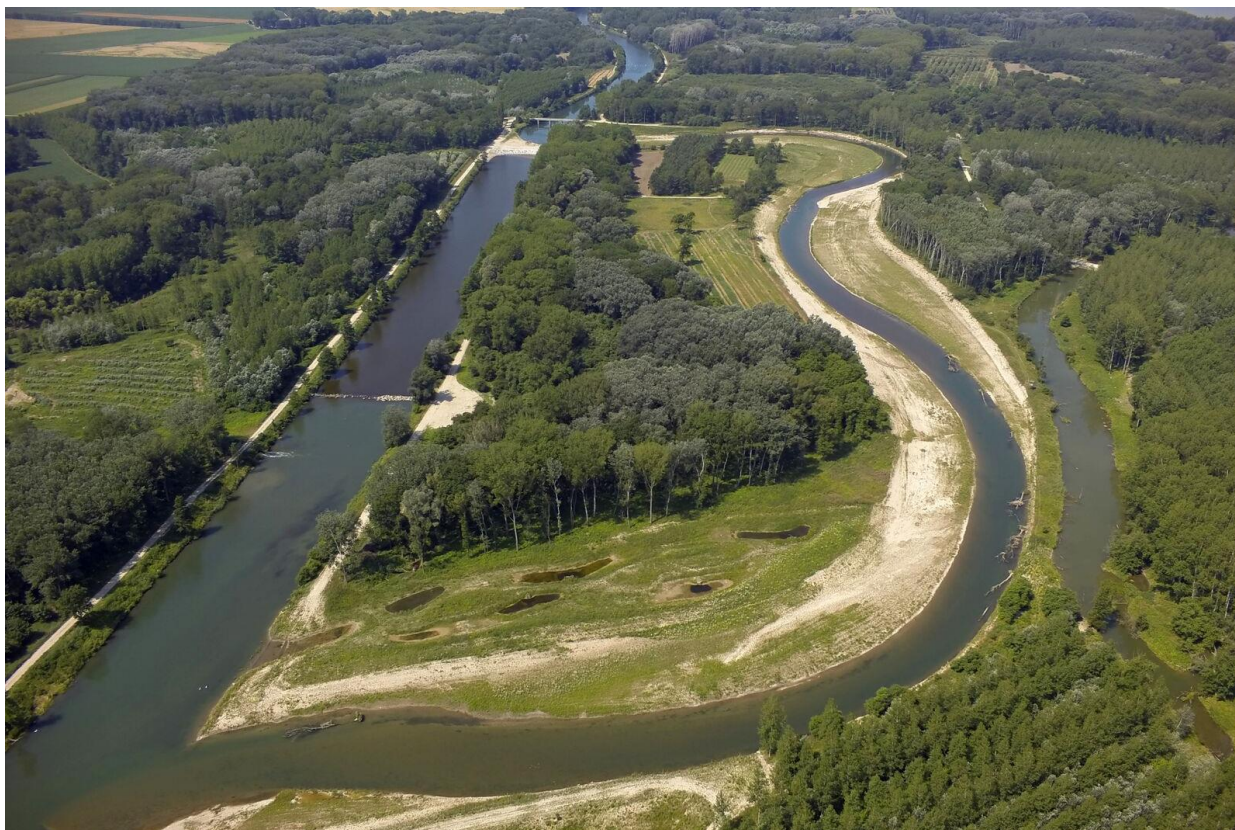
Abb. 5 oberster Bauabschnitt ca. 1 Jahr nach Flutung (Foto G.Pock)
