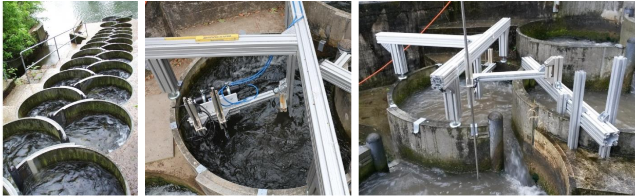
Abb. 3 Anlage C-Pass Höxter, links: Gesamtanlage, mittig: Bestimmung Fließgeschwindigkeiten im Becken (3d-Vectrinosonde, zweifach), rechts: Geschwindigkeitsermittlung im schlitznahen Bereich mittels 1d-Flügel
