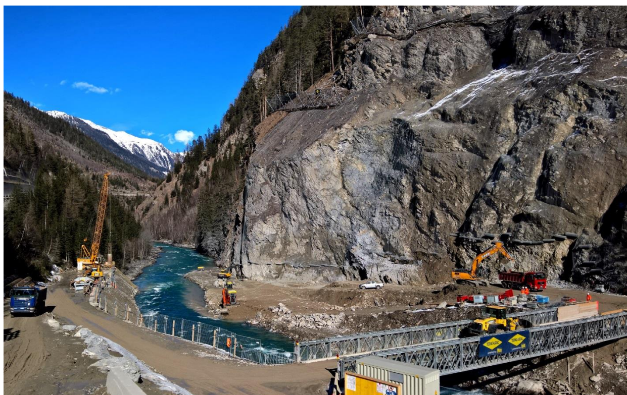
Abb. 3 Baubereich der Wehranlage nach Schuttkegelabtrag
