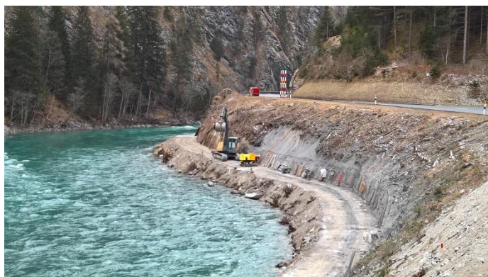
Abb. 2 Baumaßnahmen für Ufersicherung und neuen Radweg im Stauraum Martina
