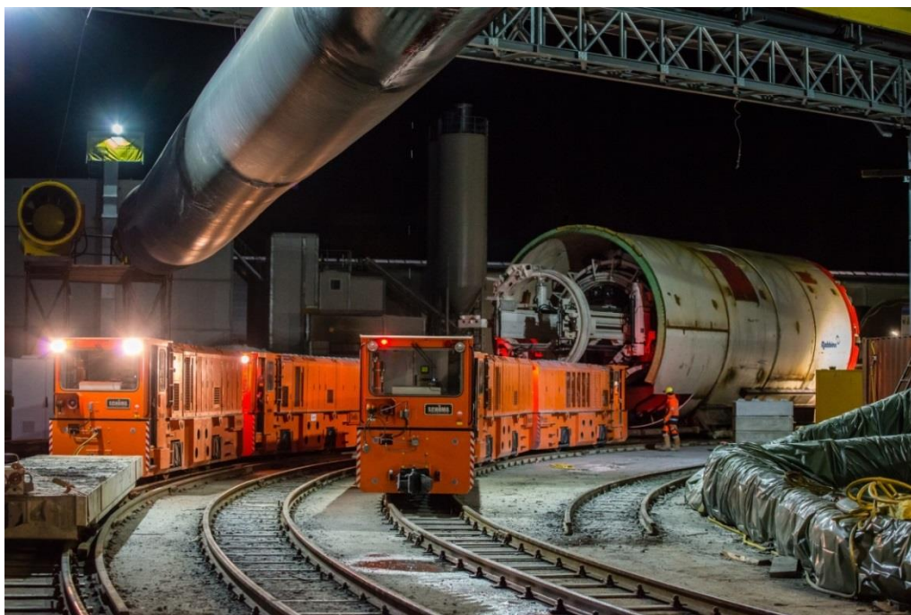
Abb. 6 Transport eines TBM-Bohrkopfes zum Montageort
