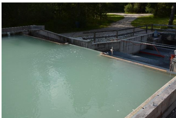
Abb. 5 Wirbelfreie Zuströmung (li.), leichte Wirbelbildung ohne Überfallströmung
