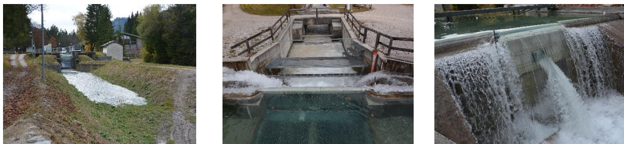
Abb. 9 Geschiebespülung mit Unterstützung der Rechenreinigung
