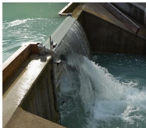
Abb. 2 Überströmte Verschlussstafel (li.) und Triebwasserweg mit KW-Längsschnitt
