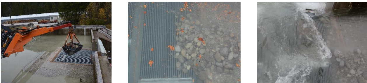
Abb. 11 Transport von Grobgestein mit dem Rechenreiniger und durch Spülung
