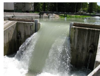
Abb. 6 Betriebszustände: KW-Betrieb mit Geschwemmsel (li.), Rechenreinigung (mi.) HW-Spülung (re.)
