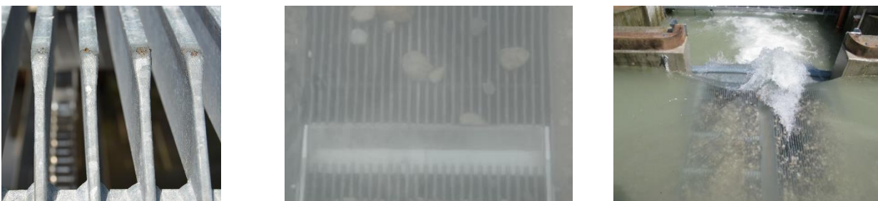
Abb. 7 Geschiebespülung mit Unterstützung der Rechenreinigung
