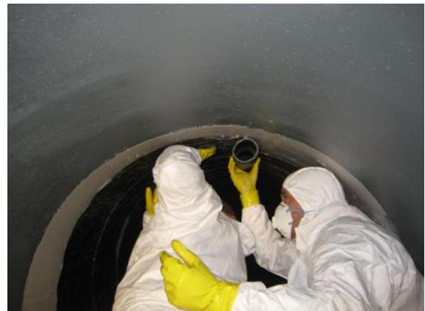
**Abb. 10 / 11** Aufrollen des C-Sheets für den Transport zum Einbauort und Applikation
