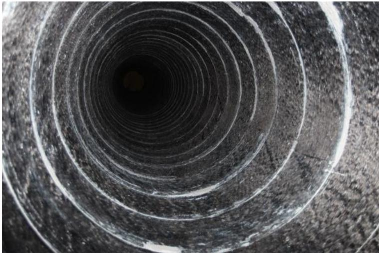
**Abb. 1** Appliziertes S&P C-Sheet 640, 400 g/m<sup>2</sup>, 300 mm breit mit 6 Umwicklungen
