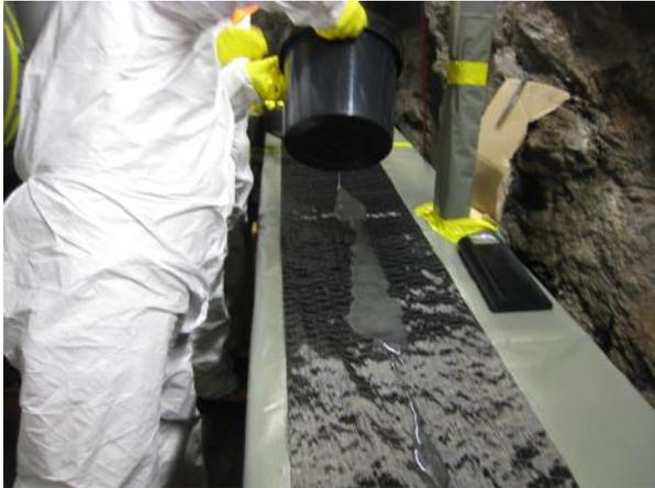
**Abb. 8** Auftragen des S&P Epoxidharzes
