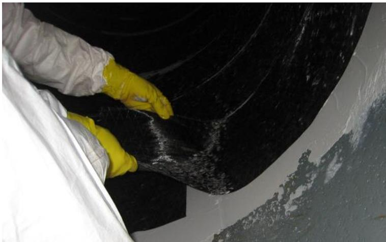
**Abb. 13** Stosslänge ist entsprechend der Dicke des Sheets wenige cm
