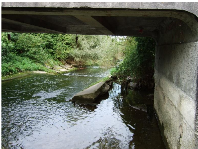
Abb. 3 Beschädigte Uferverbauung im Brückenbereich
