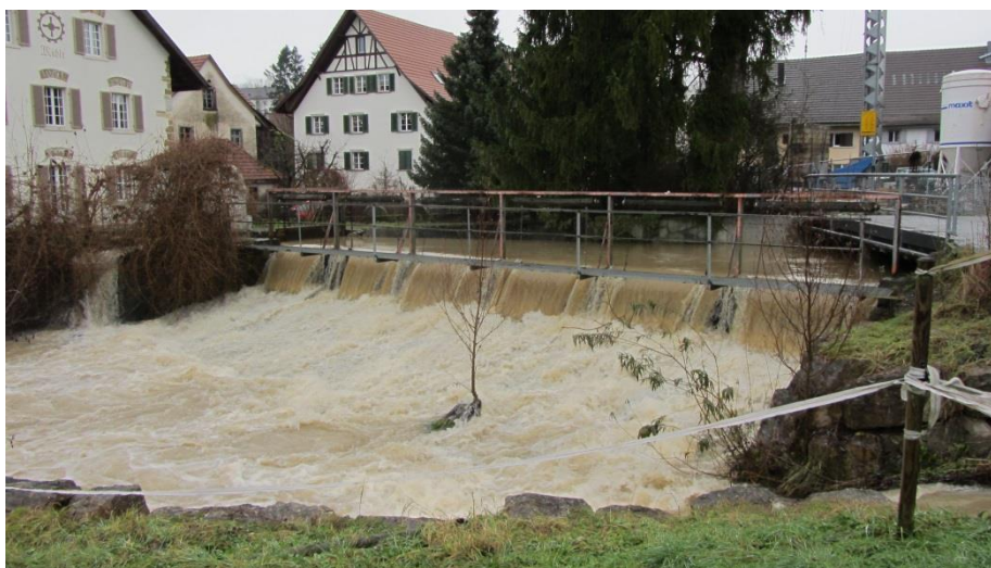
Abb. 7 Wehranlage Obere Mühle Lengnau nach einem Regen; Foto: Martin Tschannen
