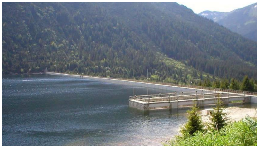
Abb. 3 Die Talsperre „Beli Iskar“: Oberwasserseite mit dem Überfall
