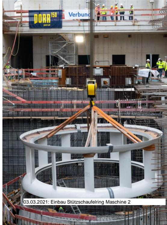
03.03.2021: Einbau Stützschaufelring Maschine 2
