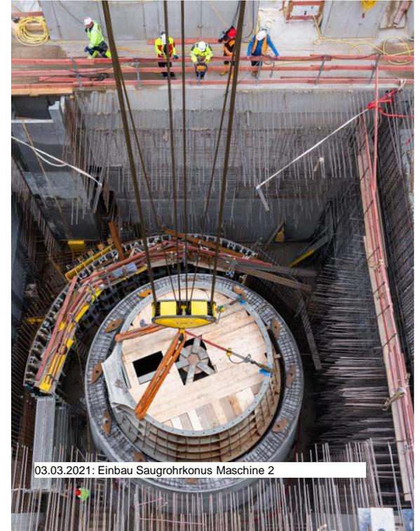
03.03.2021: Einbau Saugrohrkonus Maschine 2
